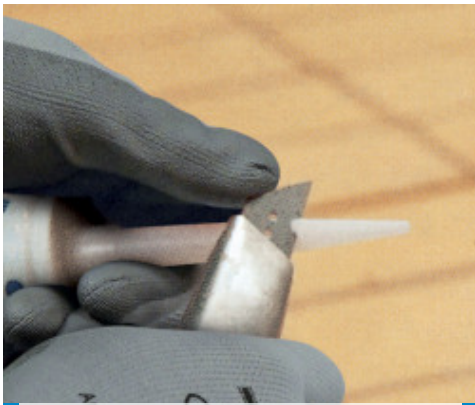
Kinyomóvég levágása a hézag méretének megfelelően
