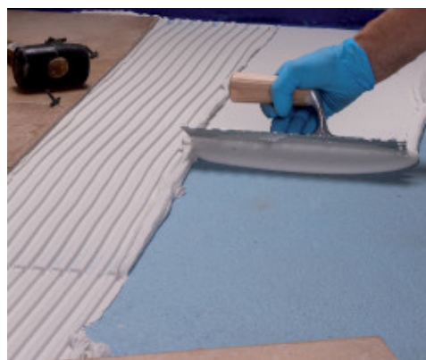
Burkolólapok ragasztása Mapelastic AquaDefense-re
