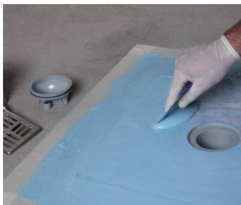
Drain Vertical impregnálása Mapelastic AquaDefense-vel
