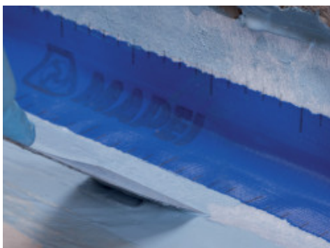
A Mapeband helyére ragasztása Mapelastic AquaDefense-vel fal és padló vízszintes és függőleges felületei között
