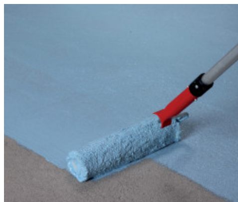
A Mapelastic AquaDefense első rétegének felhordása esztrichre
