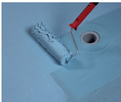
A Mapelastic AquaDefense második rétegének felhordása hengerrel
