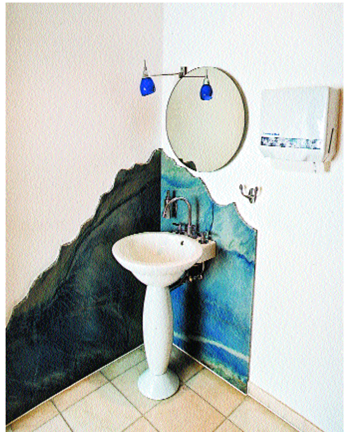
„Azul Imperial” kvarcit, ragasztás KERAQUICK-vel*
