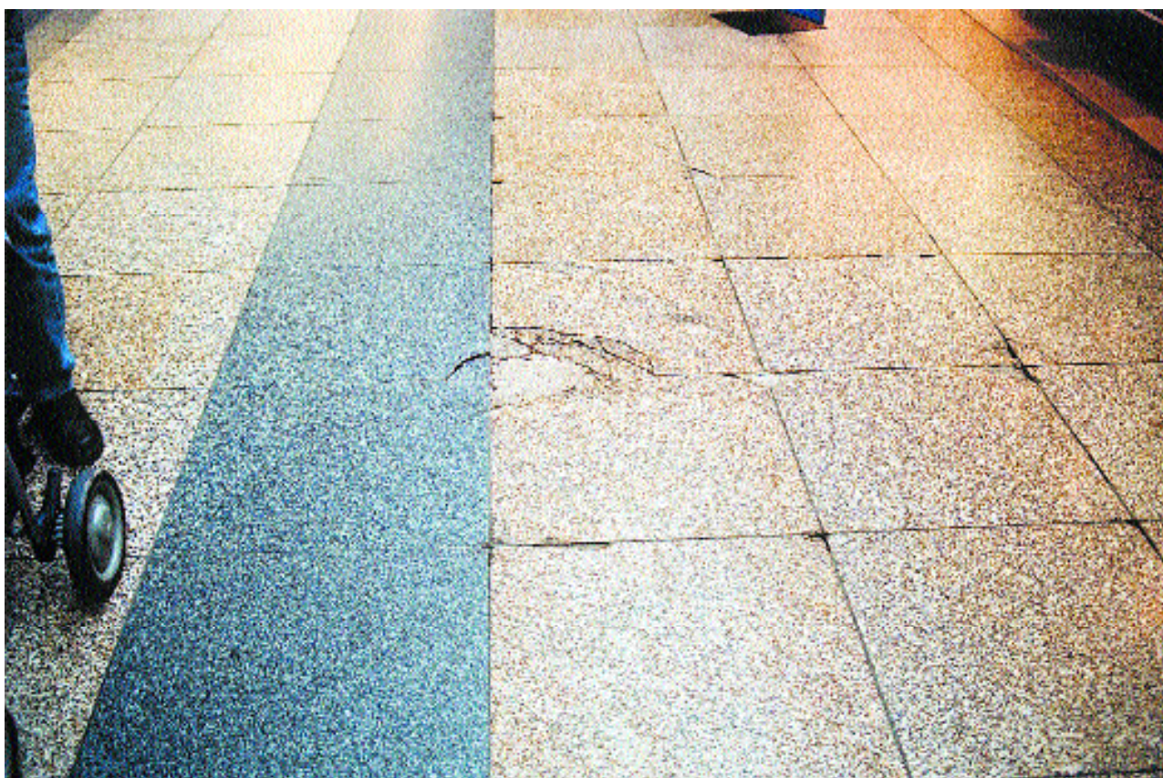
Természetes kőfelület mechanikai sérülése egy bevásárlóközpontban
