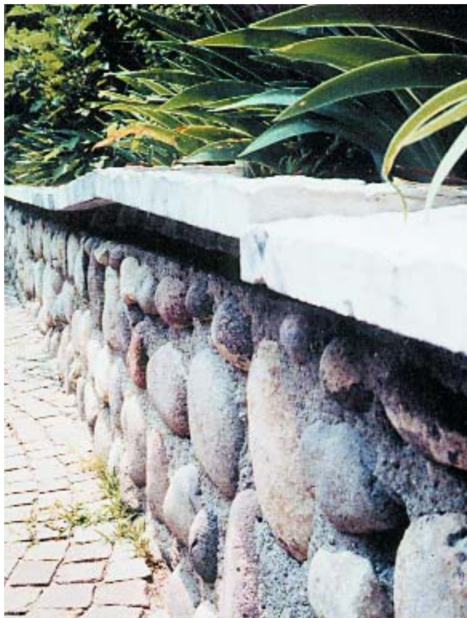
Természetes köburkolat tapadó kötőerejének elvesztése termikus hosszváltozás miatt
