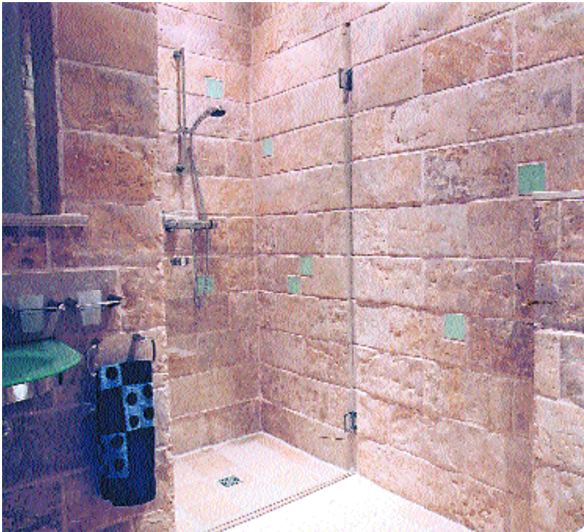
„Jerusalem Stone” mészkő, * ragasztás KERAQUICK + LATEX PLUS-szal, fugázás ULTRACOLOR PLUS-sal
