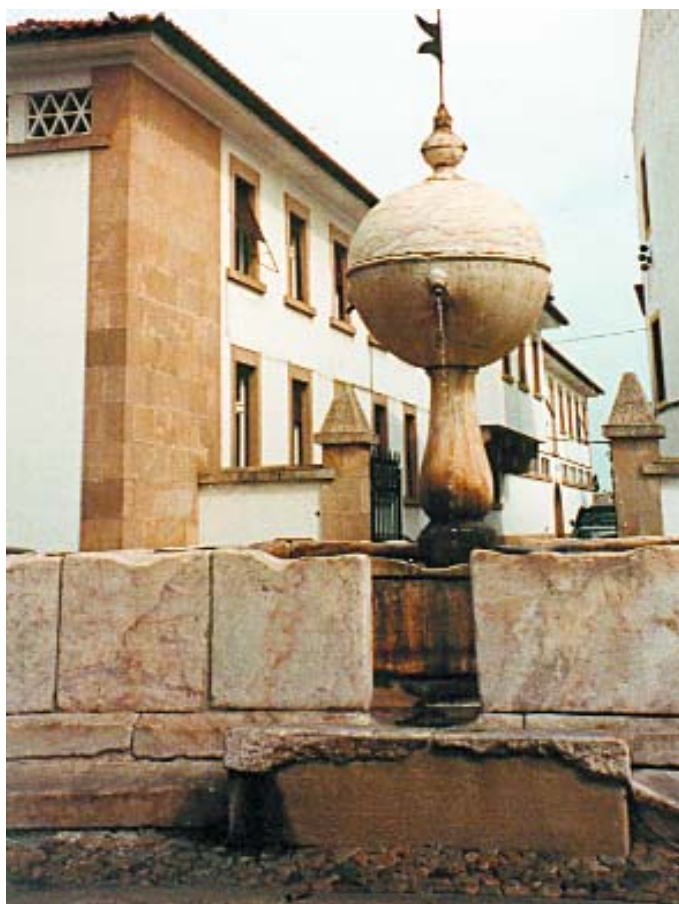
Estremoz-márványból készült szökőkút Evorában (Portugália), amelyet káros gázok támadtak meg
